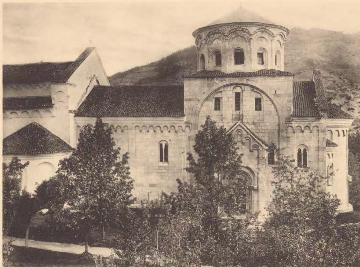
41. Eglise de Nemanja, à Studenica. Façade méridionale.
